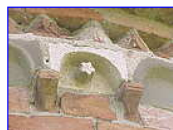
il coronamento dell'abside con archetti pensili monolitici ed il motivo a "denti di sega", particolare sopra la monofora centrale
