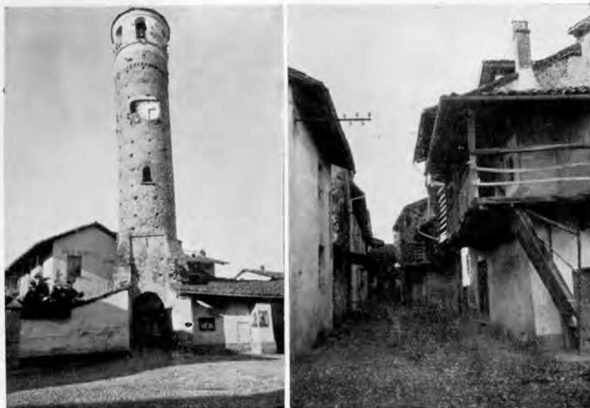
Figg. 12, 14. Ricetto di Salassa - Torre d'ingresso e contrada.
