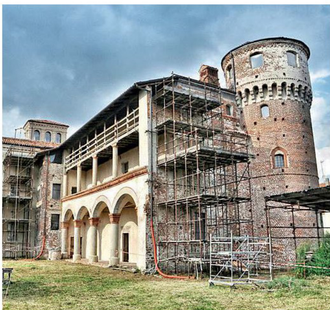
Prime impalcature al Castello di Ozegna
