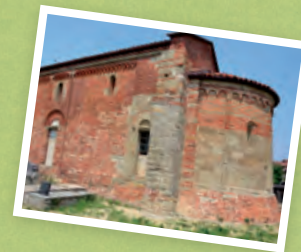
Vista esterna della Pieve di S. Maria dei Morti.
