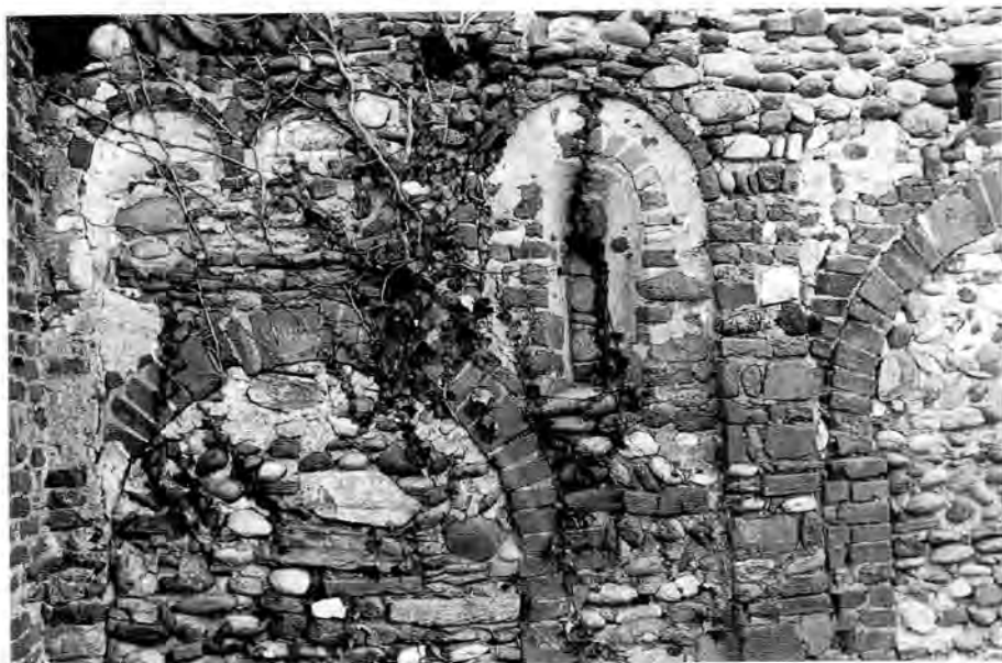
Romagnano Sesia, San Martino di Breclema, lato nord-ovest, monofora tamponata con strombatura ad archivolto. Si noti il materiale di reimpiego: laterizi di epoca romana, tra cui sesquipedali posti a coltello che perimetrano la finestra.
