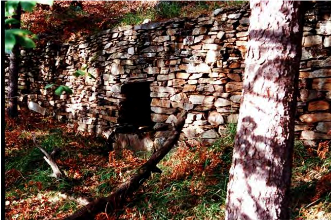
Castelluccio I – Dettaglio della struttura muraria
